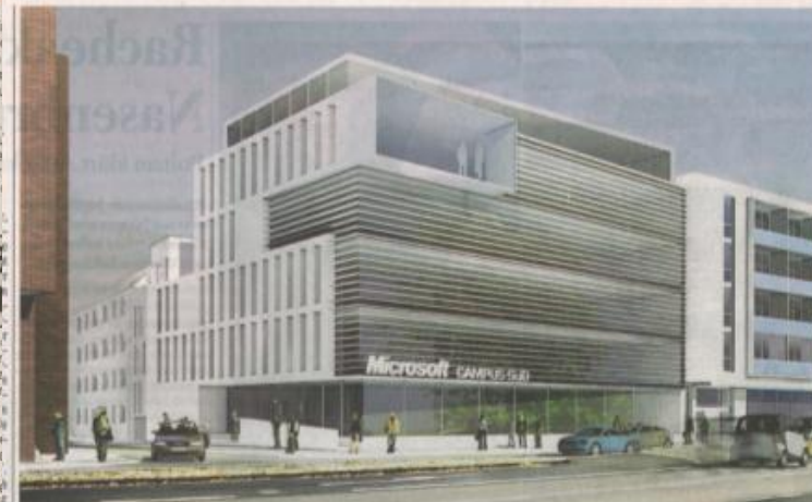
In dem Bürogebäude an der Reyastraße sollen Software-, Kommunikations- und Medienfirmen Platz finden. COMPUTERBILD: BÜRO KUBALUXA
