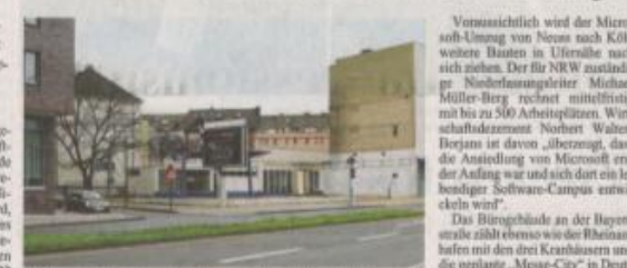
Auf dem brachliegenden Grundstück neben dem Fachgeschäft Marine Oltmanns werden bald die Bagger anrücken. BILD: HUNNE
