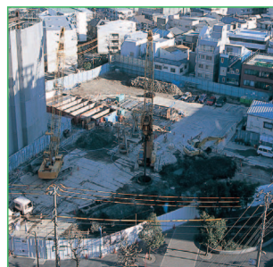
「東京シティトリエ」建設現場
